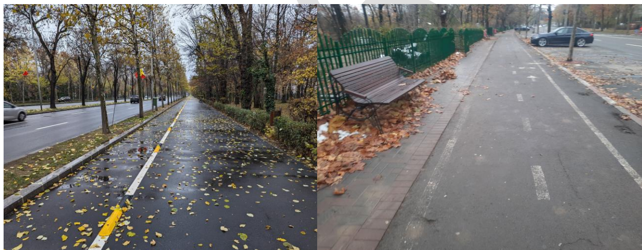
Sursa: Arhiva autorului (2023). Stânga: pistă pe trotuar cu spațiu pentru pietoni, bd. Regele Mihai I. Dreapta: pistă pe trotuar fără spațiu pentru pietoni, strada Constantin Brâncuși.
