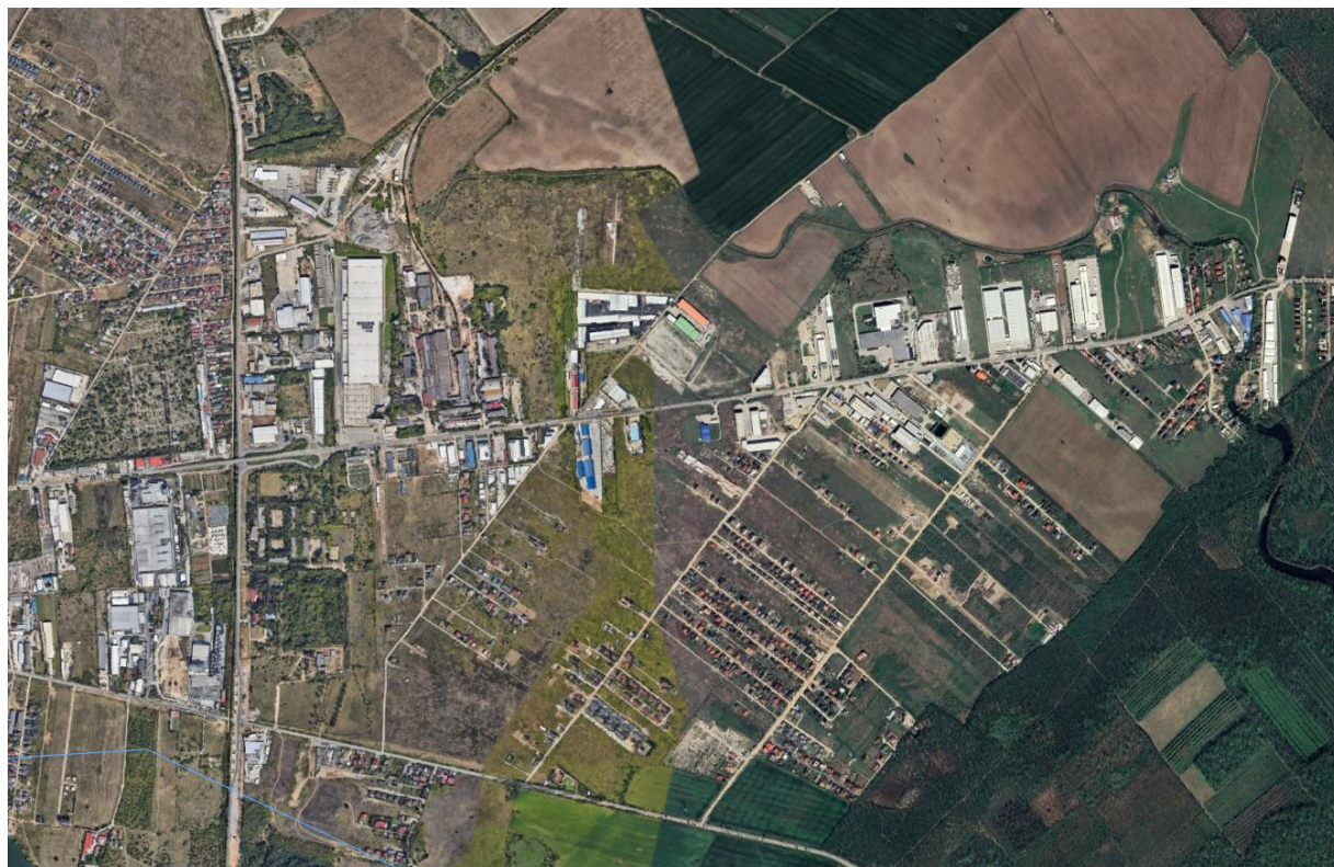
FIGURA 19. ZONE DE EXPANSIUNE FĂRĂ TRAMĂ STRADALĂ IERARHIZATĂ ÎN AFARA INELULUI DE CENTURĂ. EXEMPLU: PANTELIMON - SUS / BRAGADIRU - JOS
